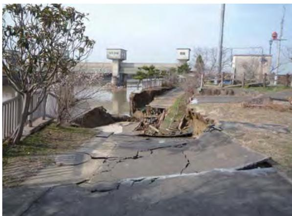
▲堰護岸崩壊状況
