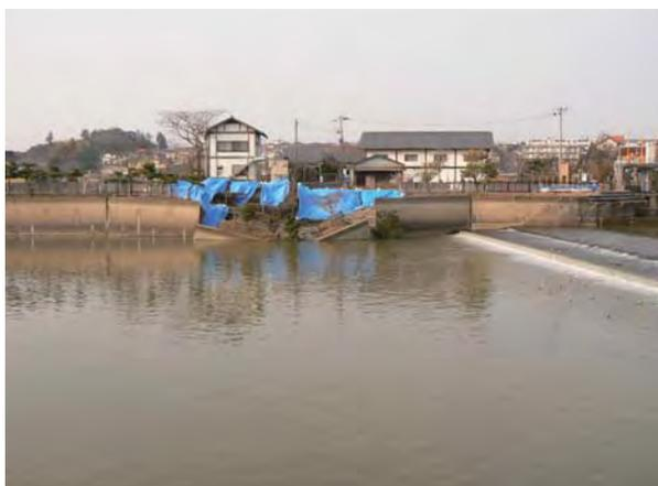
▲堰護岸崩壊状況
