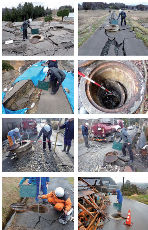
調査状況写真
