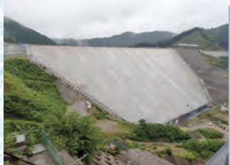
南摩ダム(上流側)
