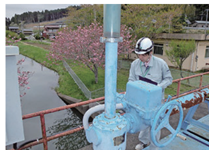
土地改良施設の診断
